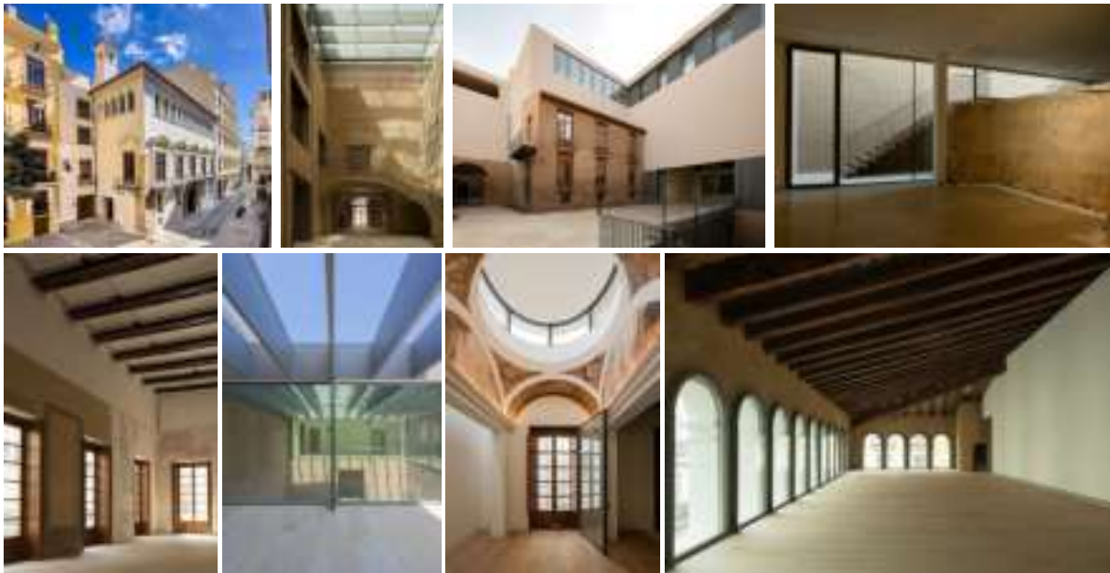
Rehabilitació del Palau de Valeriola com a Centre d'Art Hortensia Herrero - València Font: https://errearquitectura.com/
