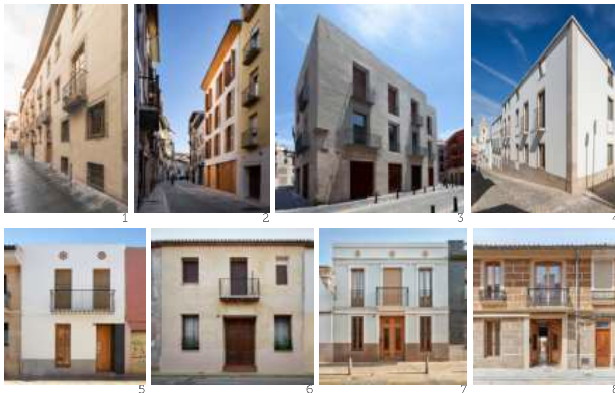
Exemples d'edificis i vivendes reformades de d'acord al seu entorn en centres històrics.
